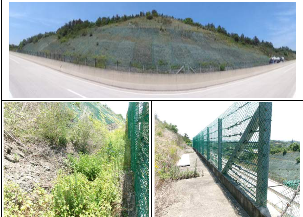
상주절토 44 (관리이정 66.378~66.678km / 8공구 STA.1+020~1+320)
